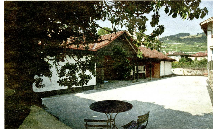
Le nouveau chai, directement inspiré par la maison du jardinier du château de Rue. K. Eichler
